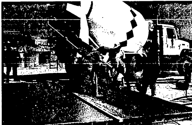
CONCRETO PREMEZCLADO EN PISOS
