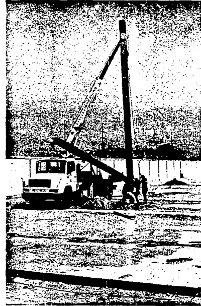
MONTAJE DE COLUMNAS METALICAS
