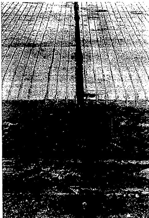
AQUI OBSERVAMOS QUE YA SE COLOCO EL MATERIAL PARA SELLAR LA JUNTA QUE EN ESTA OCASION FUE CAUCHO. SE ALCANZA A VER LA FALLA DE LA LOSA PRECISAMENTE EN LA JUNTA. LO QUE ES MUY IMPORTANTE PORQUE LAS CONTRACCIONES LAS TOMARA EN SU GRAN MAYORIA LA JUNTA.
