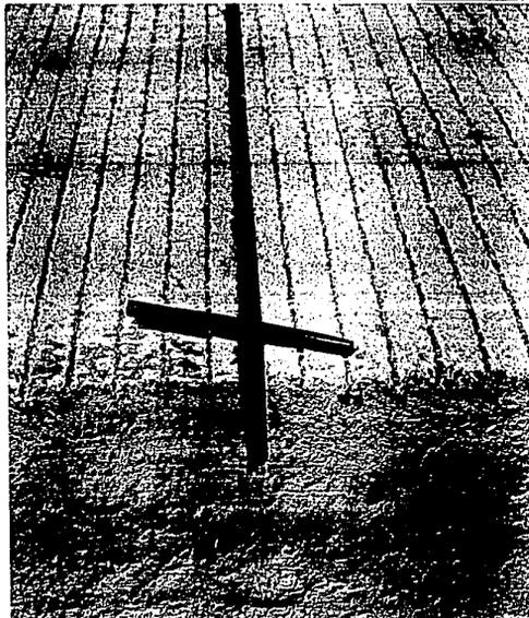
EN LA PRIMERA FOTOGRAFIA PODEMOS APRECIAR LA RANURADORA PARA LOSAS, EN ESTA OCASION HACIENDO LAS JUNTAS TRANSVERSALES. EN LA FOTOGRAFIA DE ABAJO VEMOS LA JUNTA TRANSVERSAL YA RANURADA ANTES DE PONER EL MATERIAL DE SELLO. NOTESE EL ACABADO TRANSVERSAL DE LA LOSA PARA EVITAR EL DERRAPAMIENTO DE LOS VEHICULOS.
