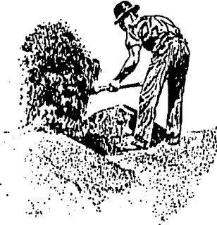
fig 38 Mezclado manual de Arena
