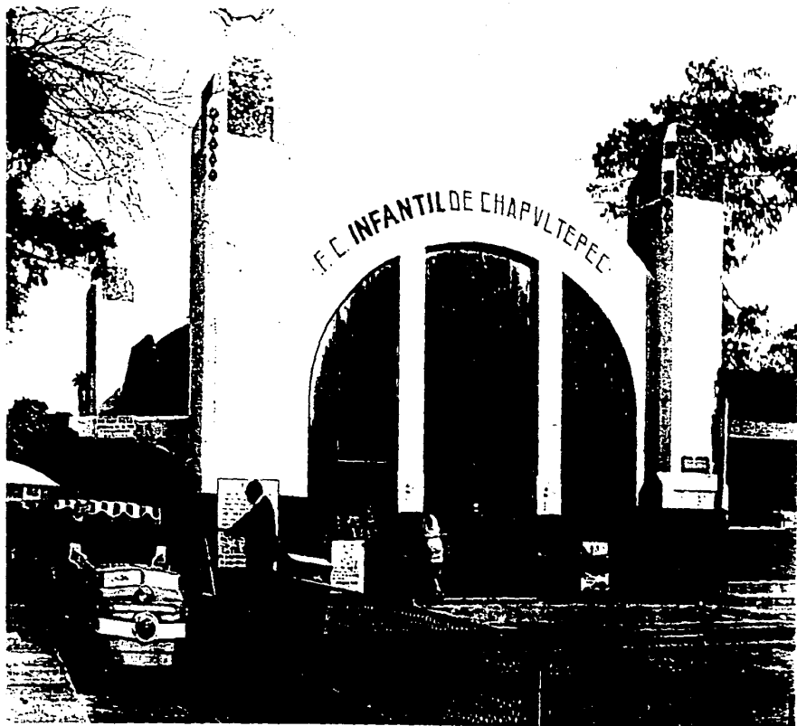
La Estación del Ferrocarril de Chapultepec (1928, del Arq. José Gómez E.) se presentó airesamente como una muestra clara de estructura diseñada monolíticamente en concreto.
