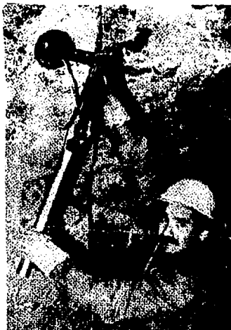
Figura II-122 Tensando anclas mediante la utilización de la llave calibrada de torsión.
