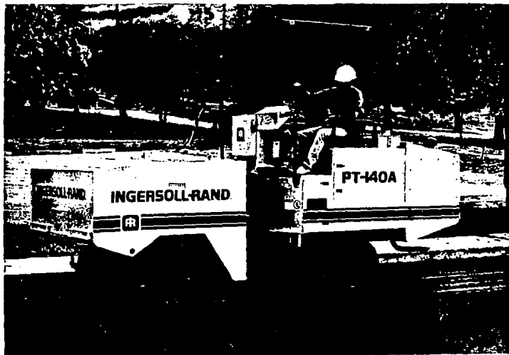
Figura III-21 Compactando un riego de sello.
