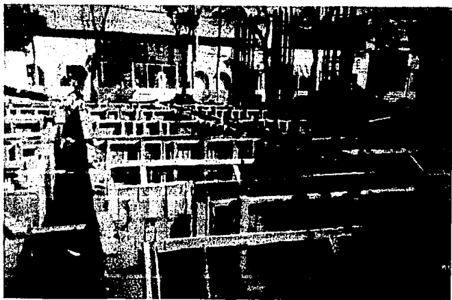
CIMBRADO DE ZAPATA
