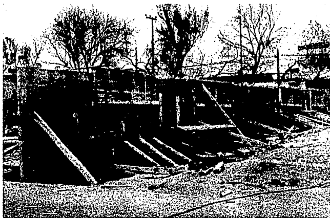
CIMBRADO DE ESTRIBO
