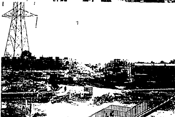
FOTO No. 2 . Obra inducida de la estación.
