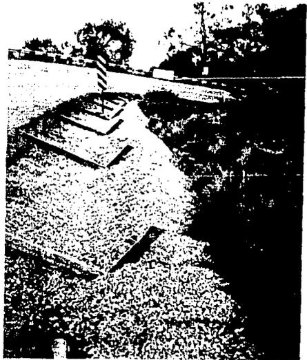
cemento. En este caso se utilizó solamente mortero de cemento arena en proporción 1:3 y mano de obra ya que las superficies a zampear no fueron muy grandes.
