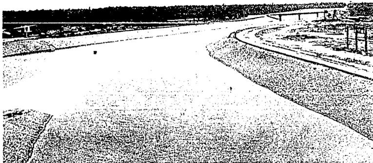
FIG. 19.- "CANAL DE LLAMADA" CONECTADO AL RIO BALSAS Y POR EL OTRO EXTREMO A LA "OBRA DE TOMA" PERTENECIENTE AL SISTEMA DE AGUA DE CIRCULACION
