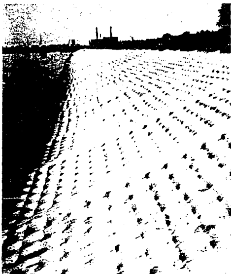
Figura 5. Concreto empacado en bolsas de plástico para contener bordos
