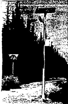
En este tipo de las células solares de silicio que vemos aquí fotografiadas en corte transversal (fotografía de la izquierda, tanto al texto), se utilizan ya en múltiples aplicaciones. Ese poste de luz de una calle en Hoavana (a la izquierda de la fotografía anterior) funciona con pilas que se recargan durante el día por medio de células solares.
