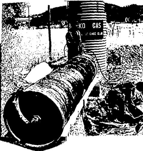
*Estas instalaciones de recuperación de gas en California, EE UU, usan el gas metano liberado en un basurero para obtener electricidad. Se recoge el gas y se produce vapor para alimentar a un generador.*
