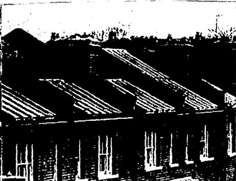
Tableros solares para el calentamiento de agua
