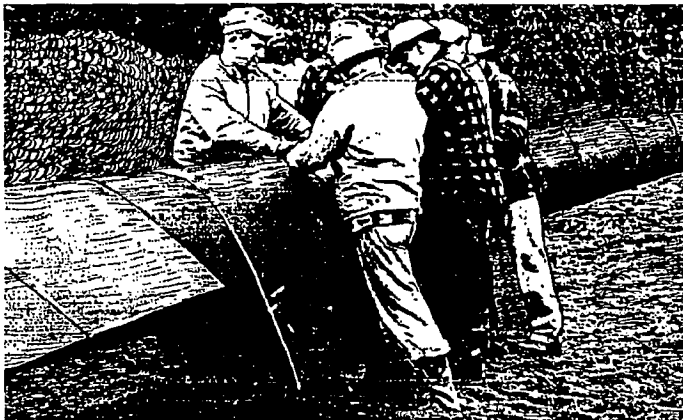
Figura 4.11: El rock shield protege a la tubería en suelos rocosos.
