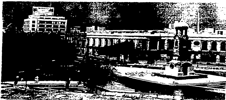
El "Reloj Chino", en la antigua glorieta de la Victoria.
