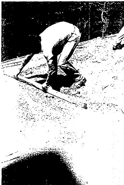
Cuando el concreto se ha vaciado, se inicia el "regleado", que consiste en repartir uniformemente el concreto sobre la superficie de la losa. Esto se hace con una regla de madera, de - allí el término.
