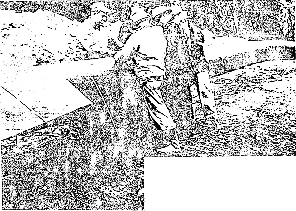
Figura 4.11 El rock shield protege a la tubería en suelos rocosos.
