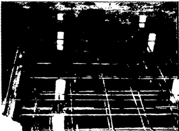
3.11 Distribución del armado, placas de anclaje y tubos de PVC de la losa de cimentación.
