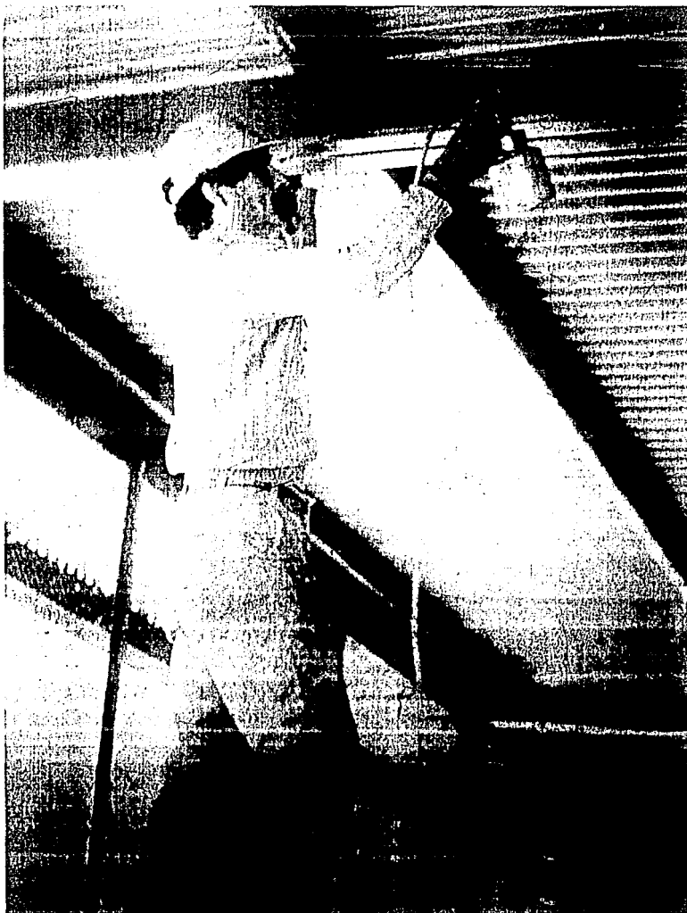
Ilustración 9. Aplicando el primario para pintar las estructuras metálicas internas de los techos.
