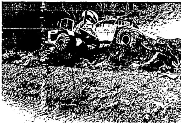
**Material B.** - Material que por su extracción y carga sólo puede ser excavado eficientemente con tractor de orugas y con cuchilla de inclinación variable de 140 - 160 HP, con pala mecánica con capacidad de 1.00 m<sup>3</sup> mínimo, sin el uso de explosivos, aunque por conveniencia se utilicen éstos para aumentar el rendimiento o bien puede ser aflojado por arado de 6.0 Ton., remolcado por tractor de orugas de 140 - 160 HP en la barra (Ver foto III.2)
