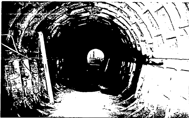
Aspecto del túnel mixto (L3A-L3B) terminado faltando únicamente la etapa de revestimiento definitivo.
