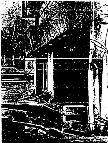
Fig. 11: Inclinación provocada por terremoto y asentamiento de un edificio sobre una cimentación parcialmente compensada
