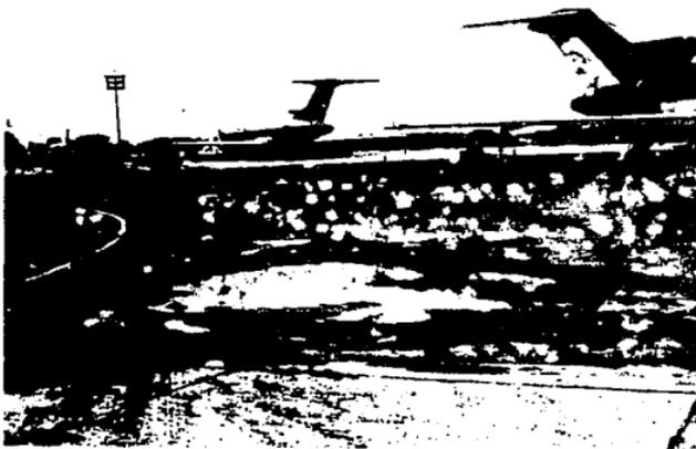
B-6 La fotografía muestra hundimiento de losa.
