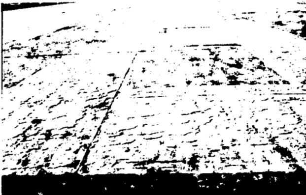
C-7 En la fotografía se observa la cascara que se ha formado con la pintura en los señalamientos
