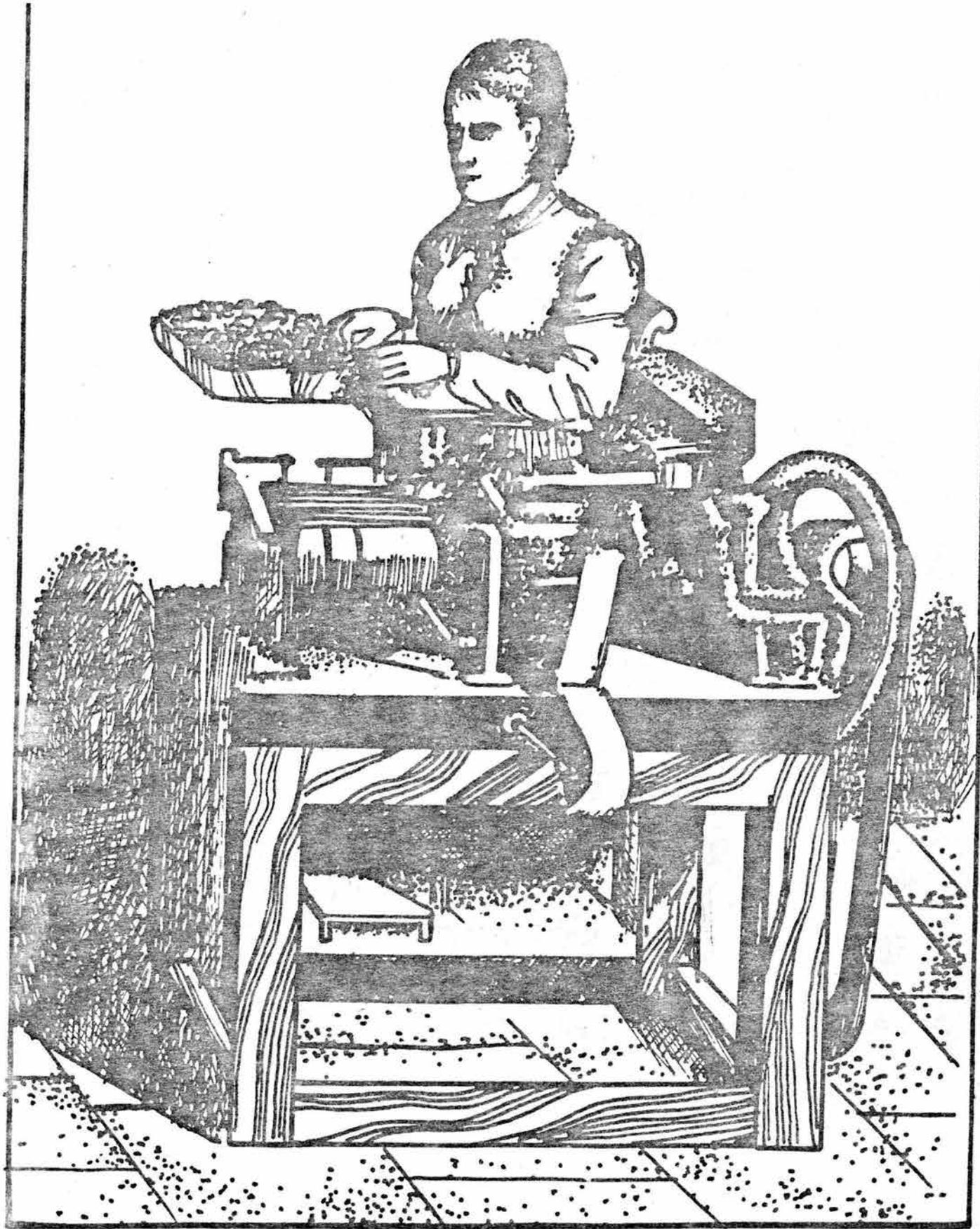
Fig. 4. Primeras máquinas para la fabricación de cigarrillos.
