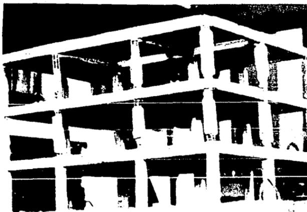
FIG. 3.7 DEMOLICION DE MICROCONCRETO EN LOS NODOS
