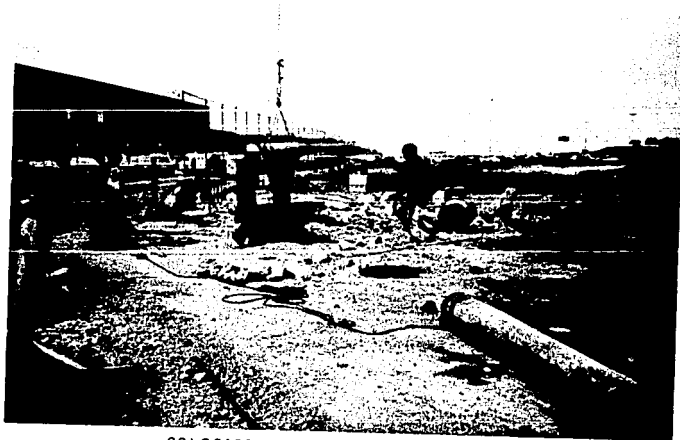
COLOCACION DEL TUBO TREMIE
