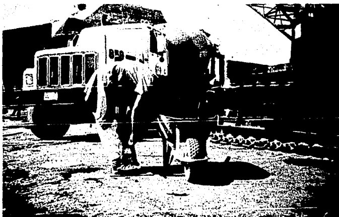
TERMINACION DEL LLENADO DEL CONO
