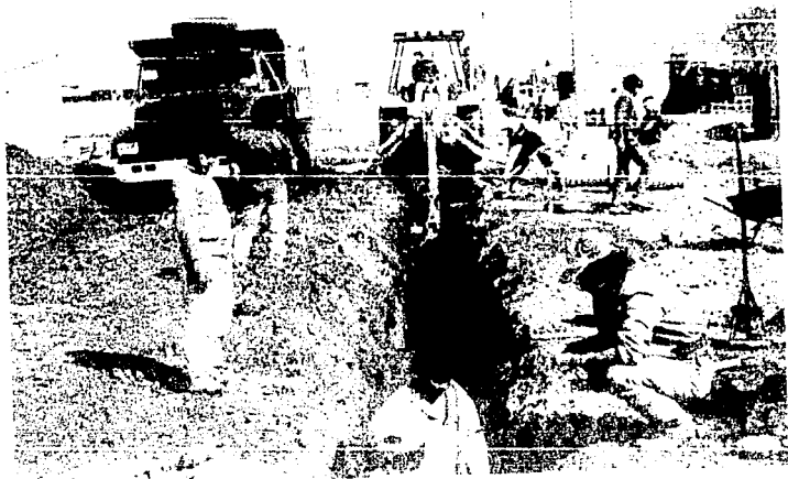
EXCAVACION CON RETROEXCAVADORA PARA ZANJA CON CARGA A CAMION.
