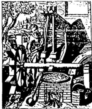
FIGURA 16. MOLINO PARA BATANERÍA DE 1617, IMPULZADO POR EL FLUJO DE UNA CORRIENTE DE AGUA (19).
