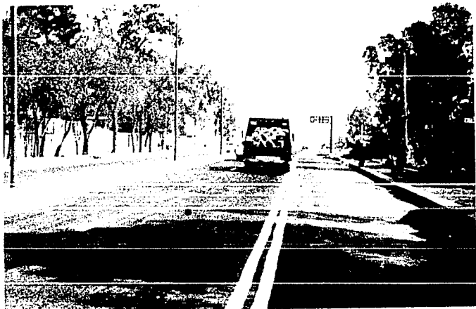
Implementación de señalamiento horizontal en Periférico.
