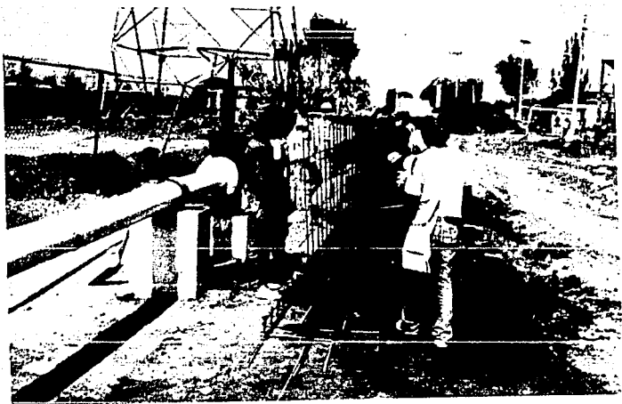
Muro de contención para protección de tubería de PEMEX.
