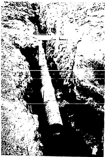
Tendido de tubería para drenaje.
