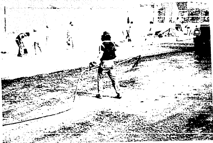
Aplicación del riego de liga sobre la base impregnada.
