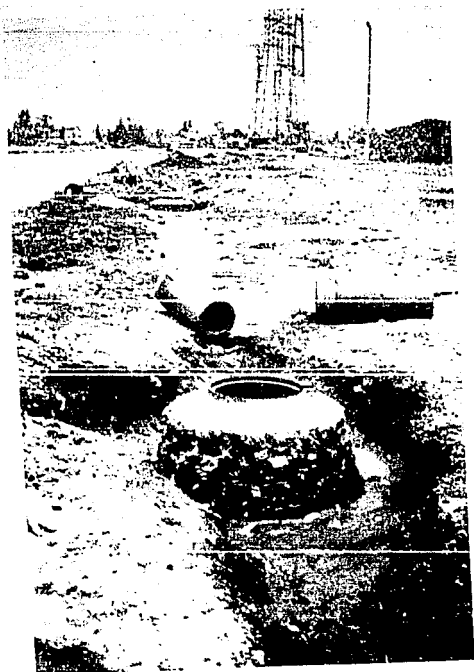
Pozo de visita para instalaciones de drenaje.
