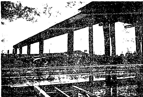
Fig.No.27. Construcción del Puente Peatonal, en al zona del Periferico Sur. Elementos prefabricados de una - sola sección, que es cubierta entre los claros.
