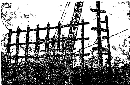
Fig.No.32. Montaje de elementos Prefabricados, Obra: Instituto Mexicano del Petróleo. México, D.F.
