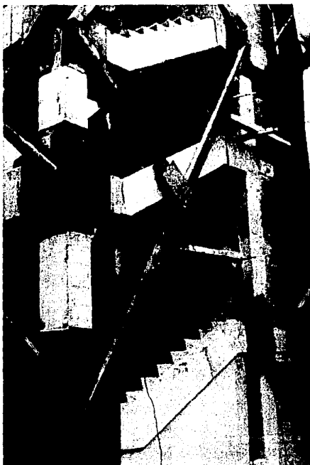
Contraventeo metálico perimetral en edificio de escaleras, que da servicio a la Torre Roma
