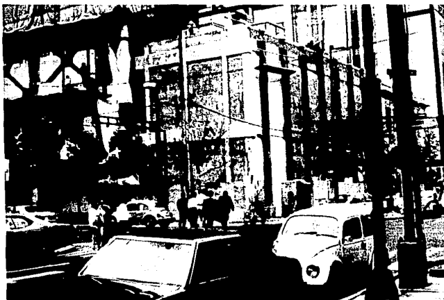
Vista de la Central Telefónica Torre Roma desde las calles de Puebla y Av. Monterrey
