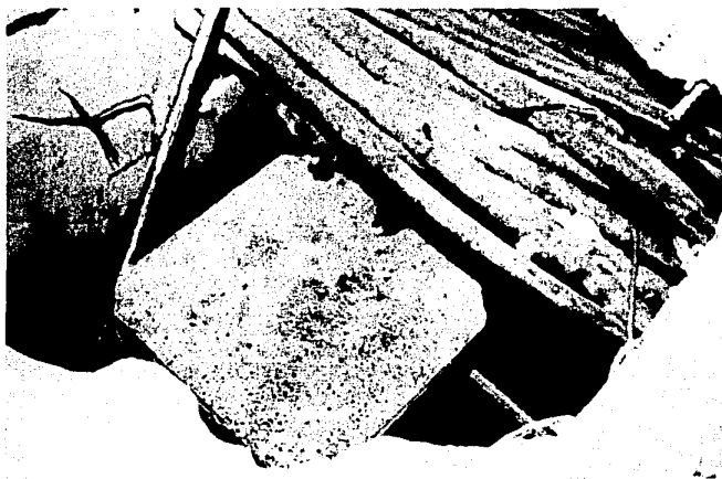
Pilote de sección cuadrada utilizado en la recimentación de la Central Telefónica Torre Roma.
