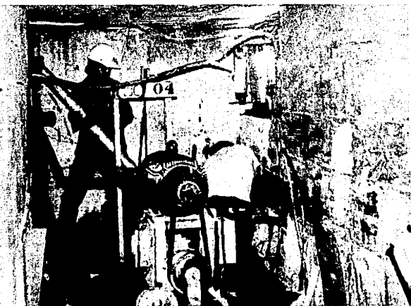
Trabajos de perforación realizados dentro del cajón de cimentación de la Central Telefónica Torre Roma.
