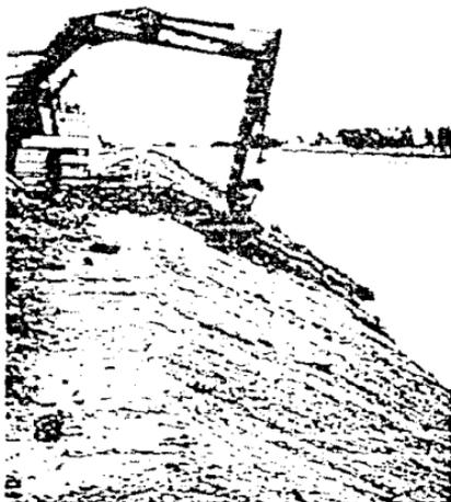
FIG. 2.10. PROCESO DE FORMACION DE UN DIQUE LONGITUDINAL A BASE DE UN TERRAPLEN.
