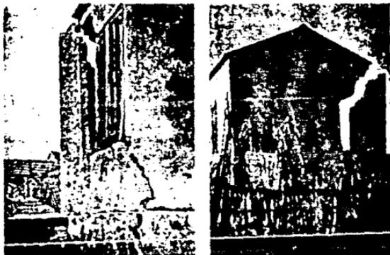
FIG. 14 CONSTRUCCIONES DAÑADAS POR LA SOCACION PRODUCIDA EN LA MARGEN DE UN RIO (Ref. 7)
