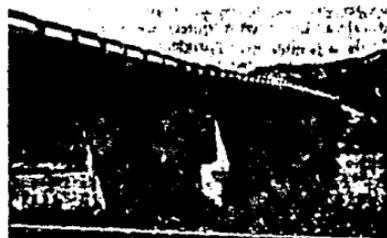
FIG. 16 UN GRAN PUENTE MOSTRANDO DEFORMACIONES POR SOCACION (RM. 51)
