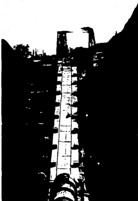
FOTO. 6 VISTA FRONTAL DEL TRAMO 6, DONDE SE PUEDEN OBSERVAR LAS SILLETAS Y LOS RIELES PARA EL CARRO DE MONTAJE.
