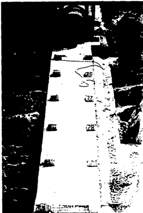
FOTO 7 VISTA FRONTAL DEL TRAMO 7, EN ESTA TOMA SE OBSERVAN LAS SILLETAS, FALTAN COLOCAR LOS RIELES PARA EL CARRO DE MONTAJE.
