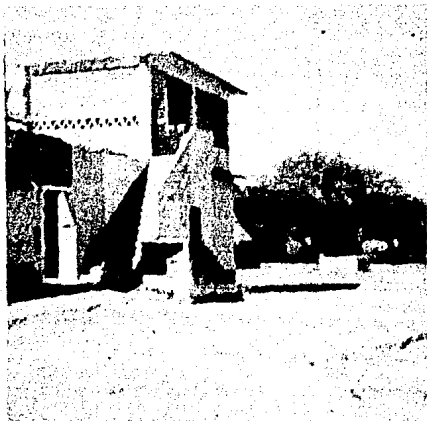
Fig. no. 25. Centro de Salud Rural Disperso --- (CSRD), colonia Alvaro Obregón, municipio de Ju chitán. El funcionamiento de las unidades de -- atención médica enfrentan diversos problemas, - situación que se agudiza en localidades margina das.
