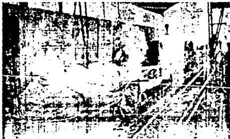
FIG.17 CURADO AL VAPOR EN UN LOCAL CUBIERTO.
