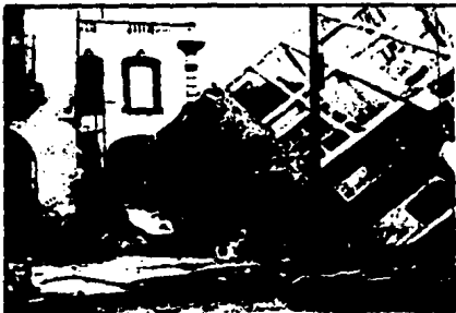
FOT. I. 7 EDIFICIO EN ES- GUNA CON EXCESIVO MOMENTO DE VOLTEO QUE NO SOPORTO LA CIMENTACION.
