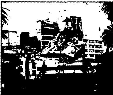
FOT. 5 VOLTEO POR FALLA DE CEMENTACION.
