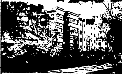
FOT. 6 EDIFICIO EN ESQUINA CON FALLA DE COLUMNAS.
