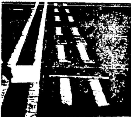
Grietas de contracción probablemente ocasionadas por la diferente absorción térmica debida a la diferencia de colores de la superficie
