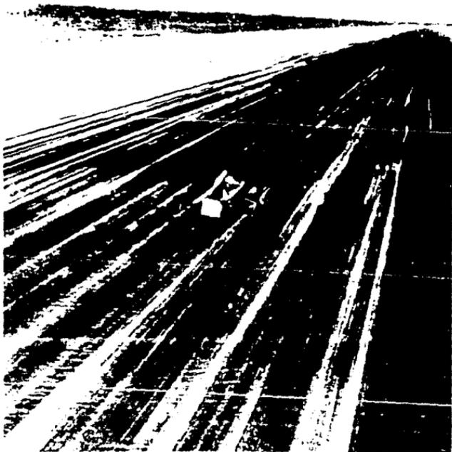
Acumulación de caucho en la superficie de la zona de toma de contacto de una pista
