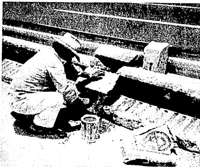
Fig. 26. Reparación de una valla de protección
