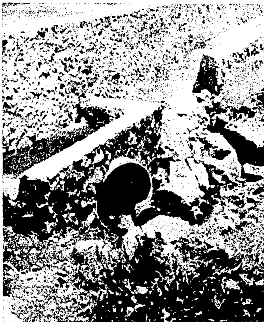
Fig. 15. Drenaje en mal estado
