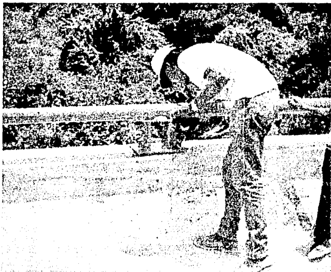
Fig. 29. Conservación de un puente
