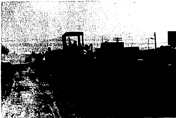
MEZCLA DE LOS MATERIALES PETRED Y ASFALTICO CON MOTOCONFORMADORA
