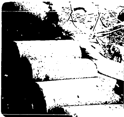
Figura 2.2.2-1. Tramos cilíndricos precolados o prefabricados
