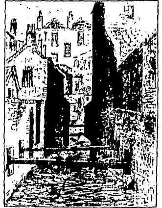
Los desagües de las casas desembocaban en una zanja
