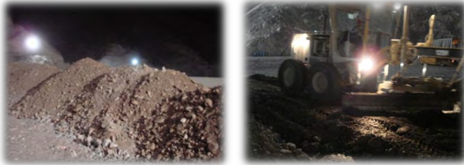
Figura 3.15 Material 3B cribado colocado en montículos (izquierda) y motoconformadora esparciendo el material (derecha).
