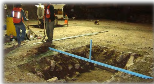
Figura 3.3 Excavaci3n terminada de la prueba Matsuo Akai, puede apreciarse la presencia de finos entre las rocas de aluvi3n
