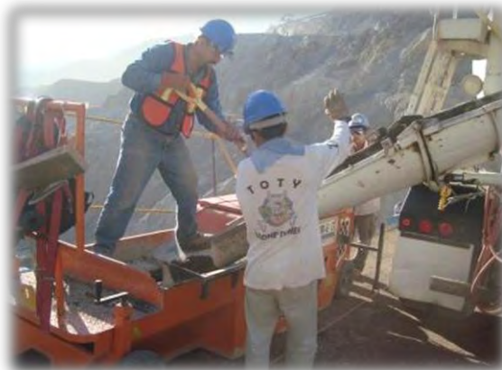
Figura 3.10 Proceso de colocación del bordillo del concreto extruido, primer paso en la colocación de una capa del material
