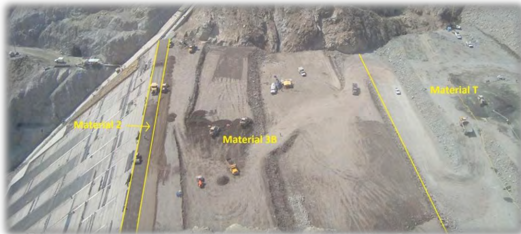
Figura 3.6 Vista de la cortina en dónde se puede apreciar la diferencia entre los materiales 3B y T en el P.H. La Yesca
