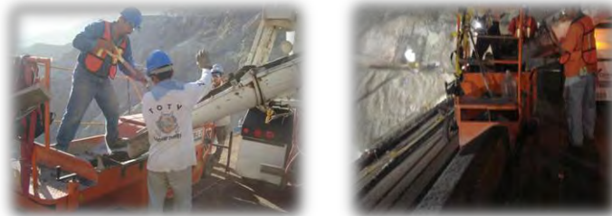
Figura 1.10 Bordillo extruido del P.H. La Yesca
