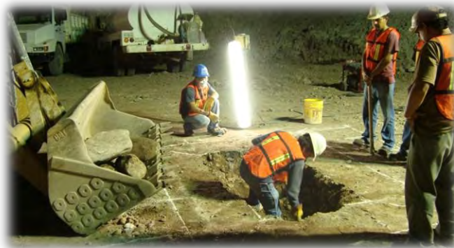
Figura 3.2 Excavaci3n de la prueba Matsuo Akai en el material 3B, el procedimiento de esta prueba esta detallado en el anexo 3.
