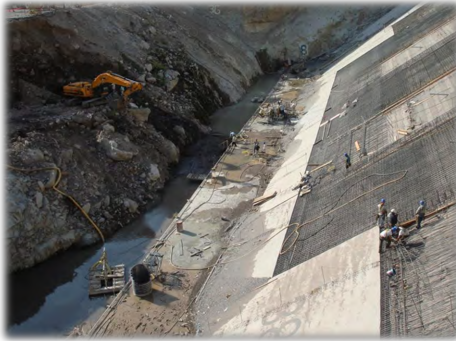
Figura 2.13 Colocación de parrillas de acero de refuerzo
