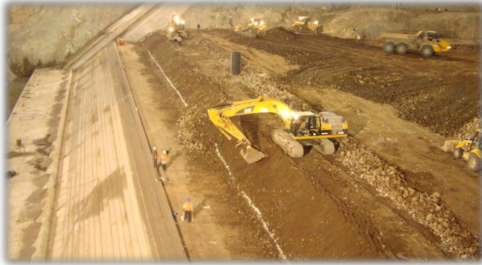
Figura 3.14 Retroexcavadora afinando el talud del respaldo de material 3B para el material 2 en el P.H. La Yesca.
