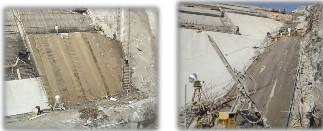
Figura 1.6 Losas de arranque P.H. La Yesca
