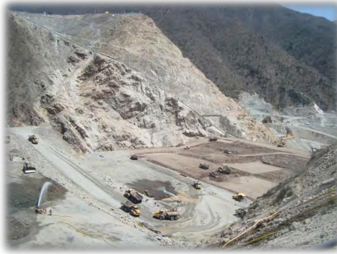
Figura 1.4 Colocación del enrocamiento, vista general del P.H. La Yesca
