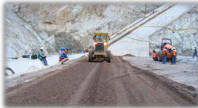
Figura 3.9 Motoconformadora colocando la primera capa de material 2 en el P.H. La Yesca
