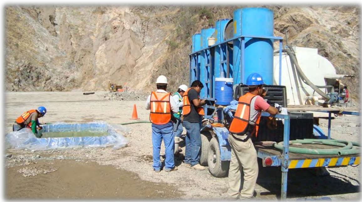
Figura 2 A-1. Realización de una Cala gigante en el material T de la cortina de ECC del P.H. La Yesca, se pueden observar las buretas utilizadas en la medición del volumen de la excavación.
