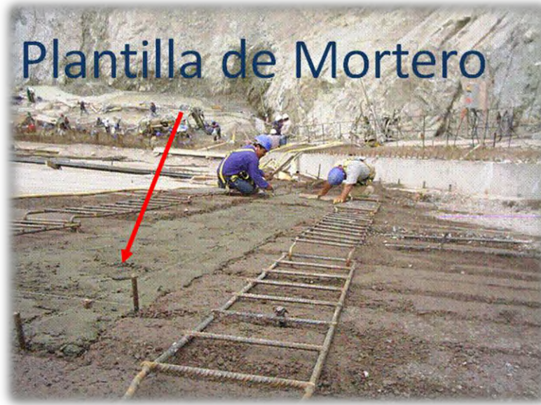
Figura 2.23 Elaboración de la plantilla de mortero.
