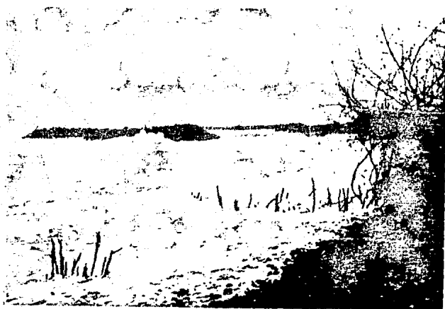
Foto 4.1. En esta fotografía se muestra claramente como un espigón ha quedado totalmente rodeado por el mar; lo que significa por un lado, que el espigón no ha cumplido con el objetivo para el cual se construyó, y por el otro, que la energía del oleaje sigue actuando sin menoscabo de los espigones.
