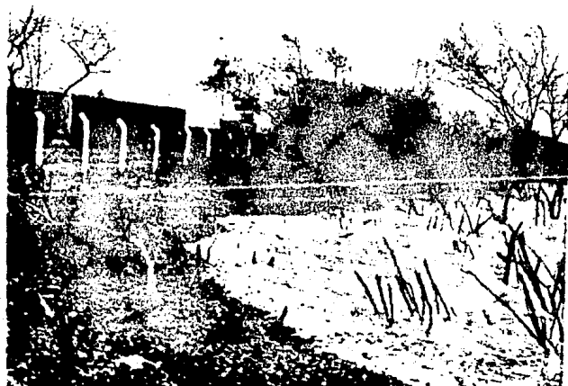
Foto 3.1. Se aprecia en la imagen la invasión del ambiente por el oleaje en primera instancia. Al fondo se observa como las olas afectan el terraplén. Nótese el tamaño de los sedimentos.
