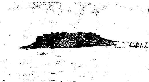
Foto 3.2 En la imagen se muestra como el oleaje afecta al espigón rodeándolo y por consiguiente arrastrando y separando los bloques que lo forman.
