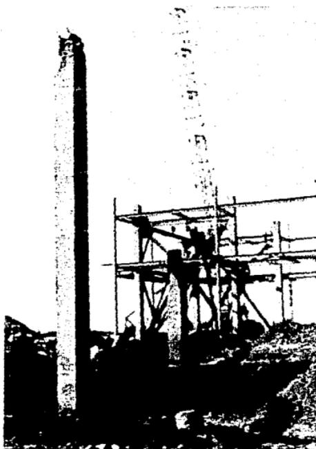
El nivel de la cabeza de los pilotes ya hincados fue variable pues la altura estuvo en función del perfil estratigráfico y de su capacidad de carga.
