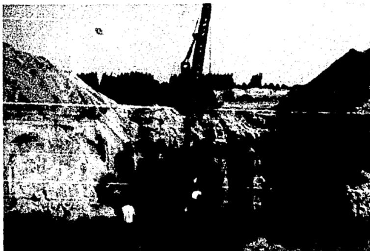
Excavacion utilizando draga de arrastre y cuadrilla para el afine del fondo de la excavacion y el tendido de drenes.
