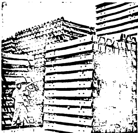
Fig. V.1.9 Almacenaje de durmiente DYWIDAG.
