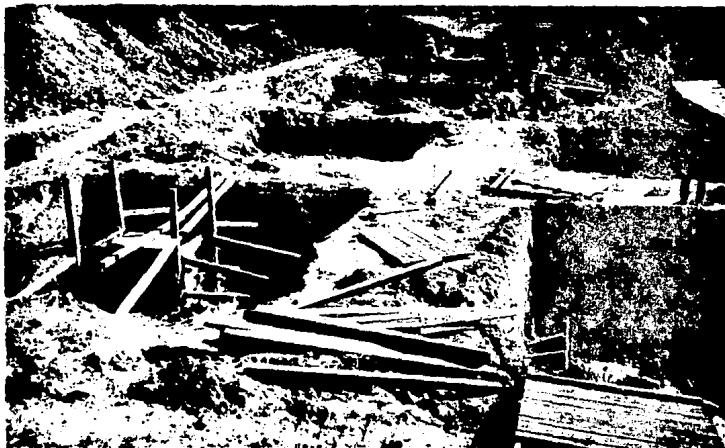
Figura # 25 .- Cimbra en la parte alta del dado de zapata (después se cuele)
