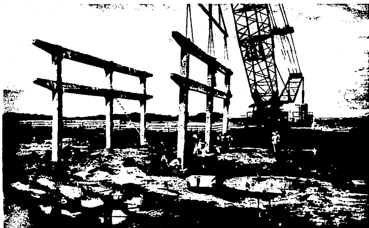
Figura # 30.- Montaje de marcos ( observar la colocación de la grúa, entre el lugar definitivo y el lugar donde fueron colados ).
