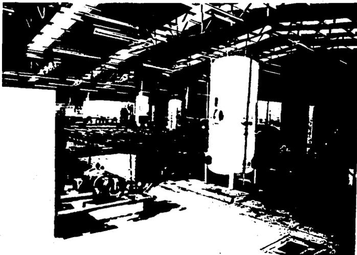
**Fig. 2.1 Bomba centrífuga y tanque hidroneumático
