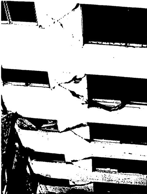
FOTOGRAFIA 9. FALLA TIPICA EN MUROS DE MAMPOSTERIA. EDIFICIO XOCHICALCO.
