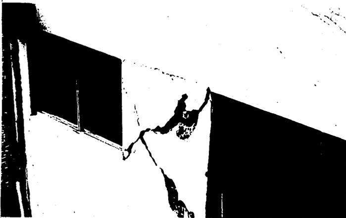
FOTOGRAFIA 10. FALLA DE MUROS DE MAMPOSTERIA SOBRE EL EJE D, EDIFICIO XOCHICALCO.
