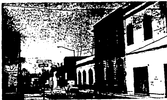
Vista de la calle de Obraje, vanda hacia el poniente
