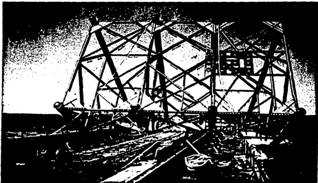
FIG. 12-A LANZAMIENTO DE LA SUBESTRUCTURA
