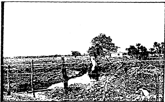
Foto 6. Canal abierto por los campesinos sobre el bordo fluvial del Usumacinta, funciona como un rompido natural que capta y distribuye sedimentos.
