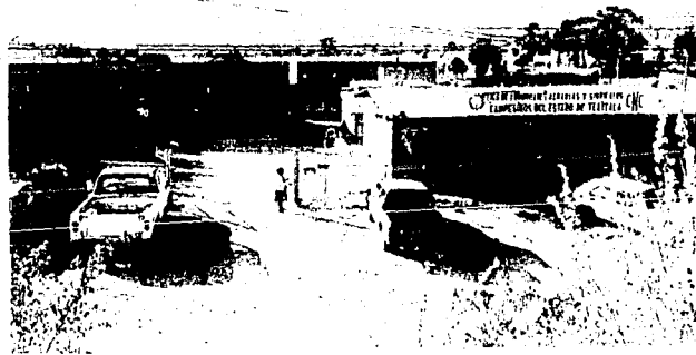
PALAPA E INSTALACIONES PROVISIONALES DE LA LIGA.
